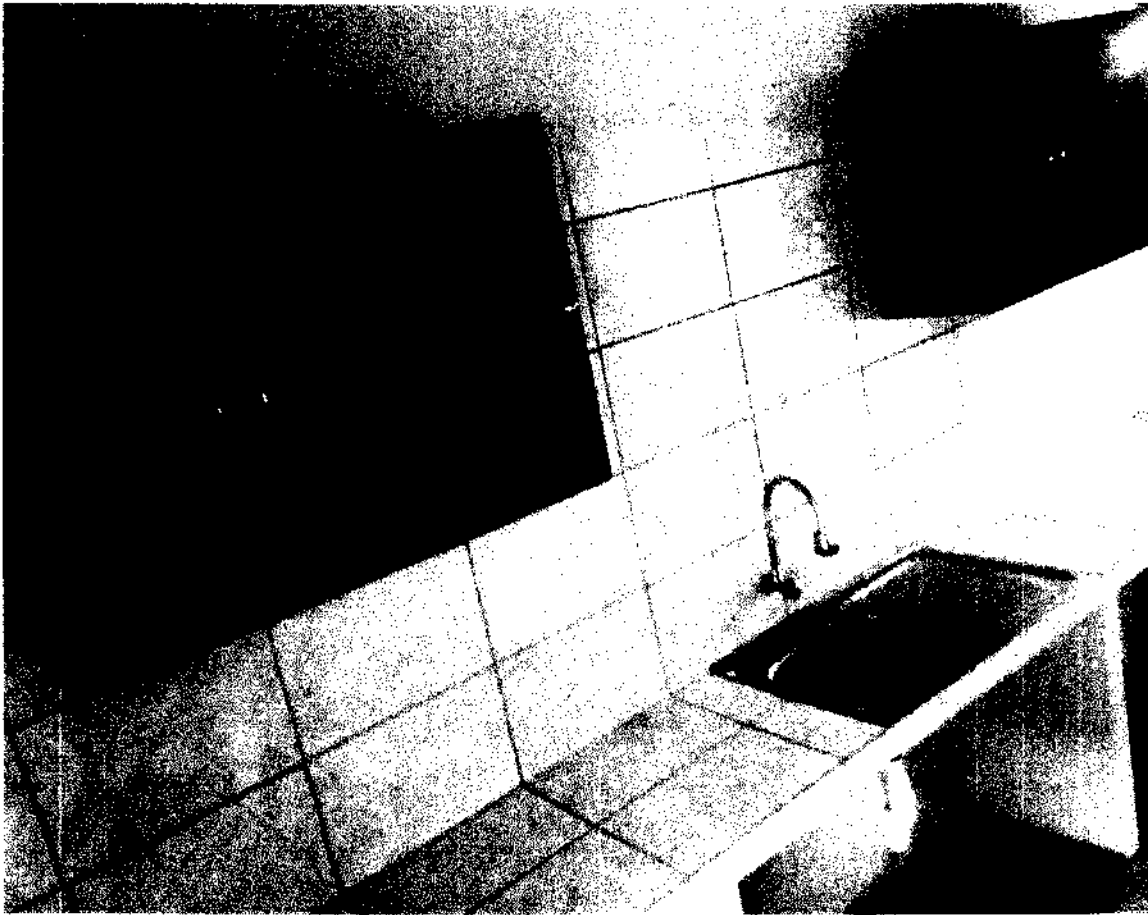
Vista del area de cocina verificado por el Supervisor y Residente de la Obra.
