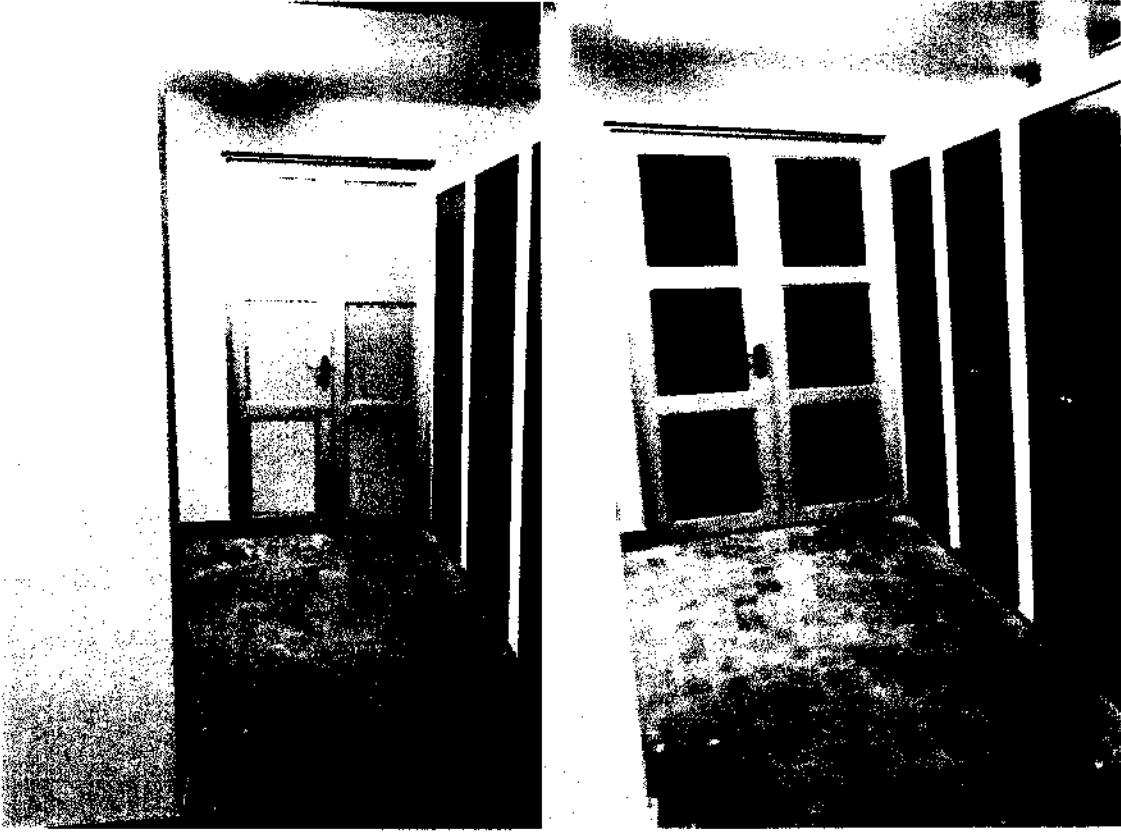
Vista de puertas colocadas en la obra.
