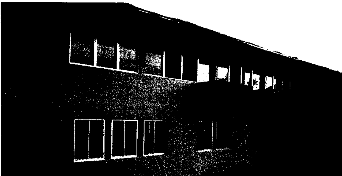
Vista de colocación de ventanas en la obra.
